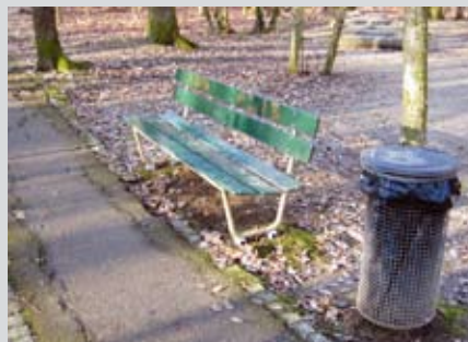
Poubelle trop proche du banc, A éviter, à cause des mauvaises odeurs, des insectes, ...
